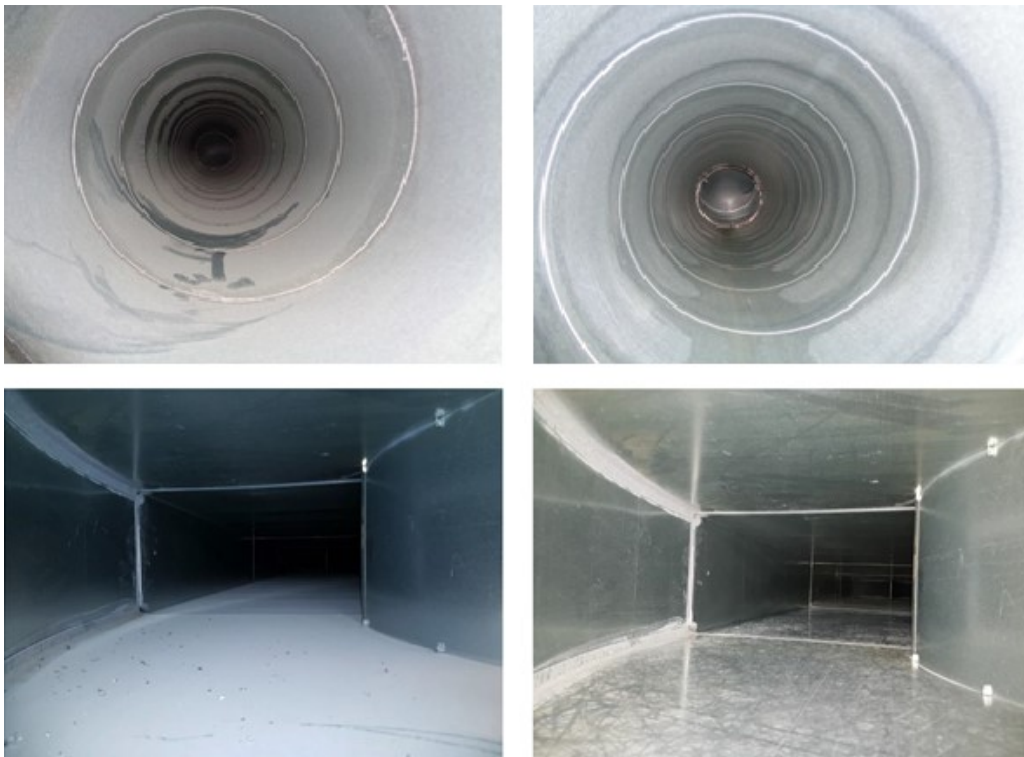
Figuur 7: Luchttoevoerkanalen voor (links) en na (rechts) professionele reiniging.
